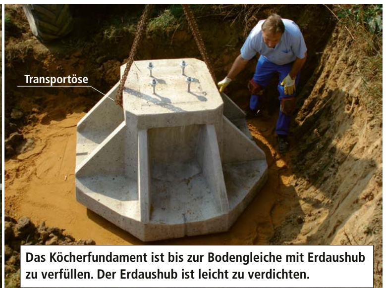
Bild 3b Köcherfundament KöFU I
