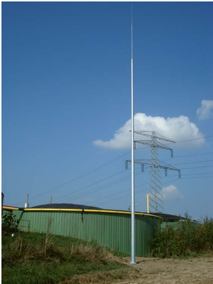
Bild 2 Biogas-Anlage mit Tele-Blitzschutzmast
