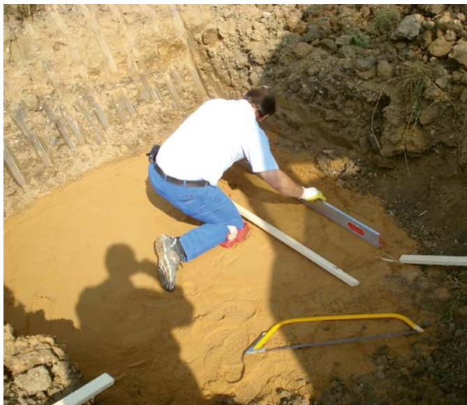
Bild 3a Fundamentgrube mit Sandbett
